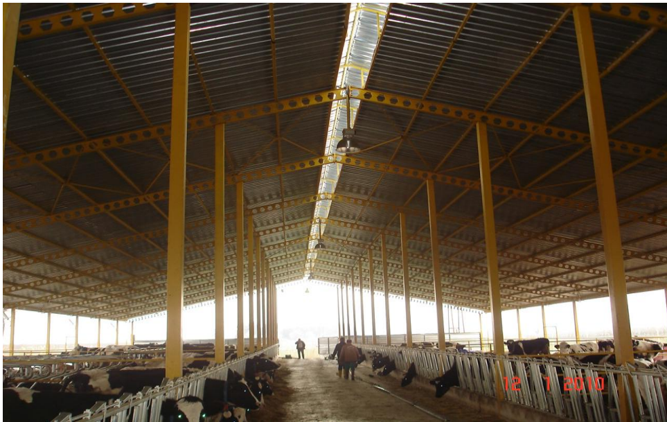
Şekil 4.7. Çatı iskelet malzemesi çelik ve çatı kaplaması trapez sac olan bir işletme (Denizli/Merkez)
