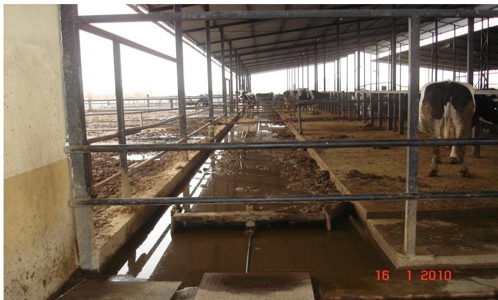
Şekil 4.17. Mekanik sıyırıcı bulunan bir işletme (Sarayköy)
