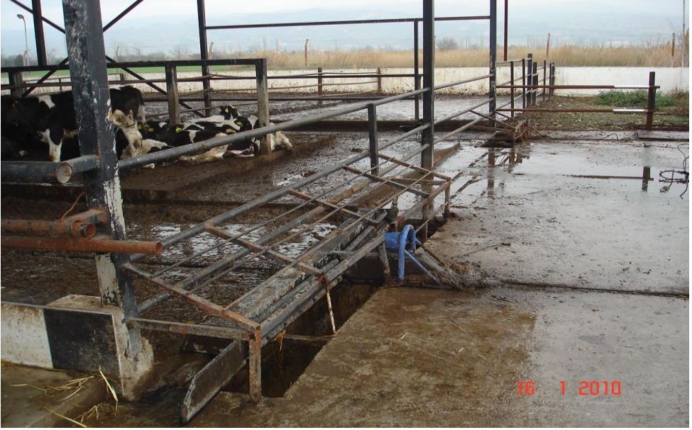
Şekil 4.33. Sızdırmaz gübre çukuruna sahip bir işletme (Sarayköy)
