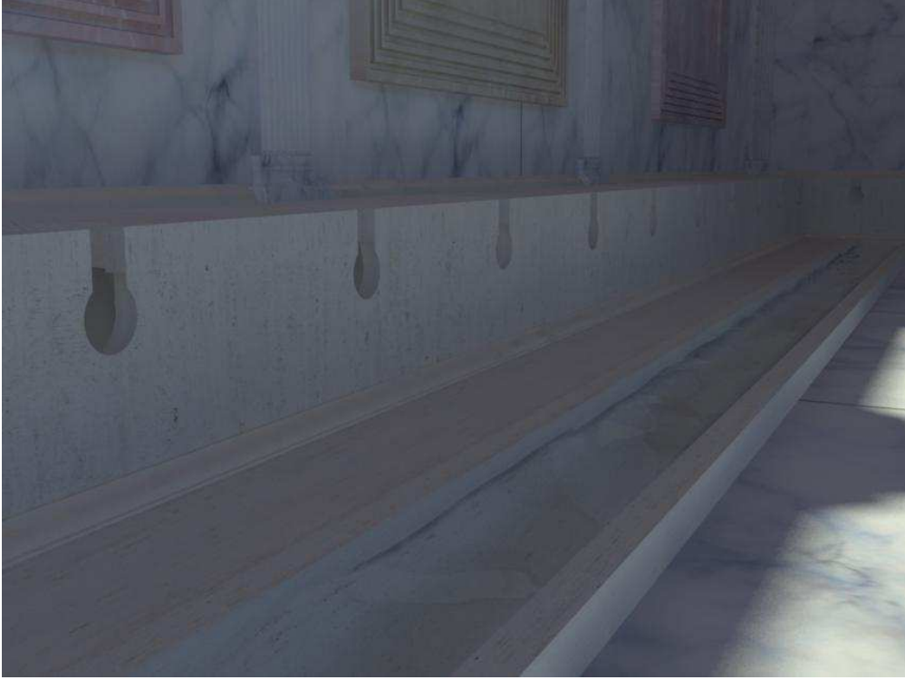
Resim 123 Oturma Plakaları ve Temiz Su Kanalları
