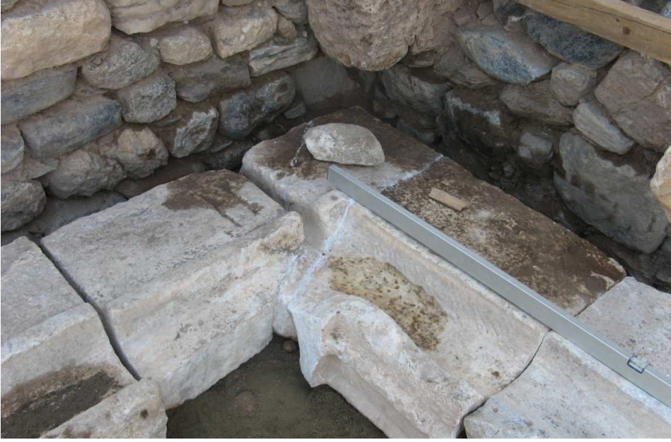
Resim 94 Temiz su kanalından atık kanalına tahliye kanalı
