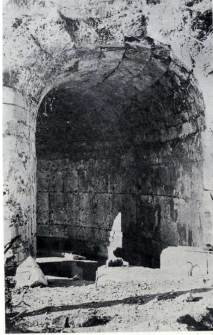
Resim 75 Side Latrinası iç kısım
