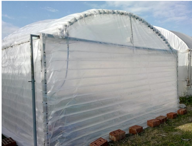
Şekil 3.29. İskelet ve örtü montajı tamamlanan sera arka görünümü
