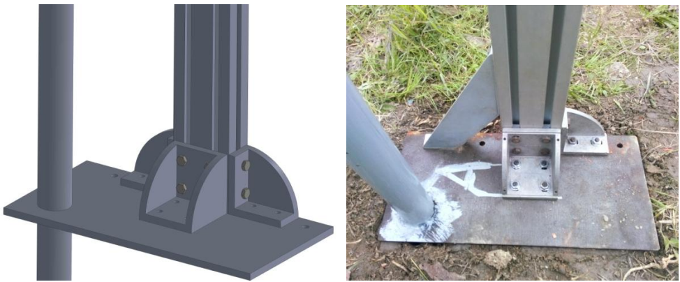
Şekil 3.14. Sigma profil zemin bağlantısı
