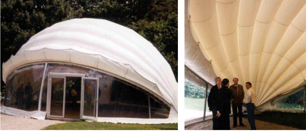
Şekil 1.3. Hava yastığı şeklinde şişirme sistemler
