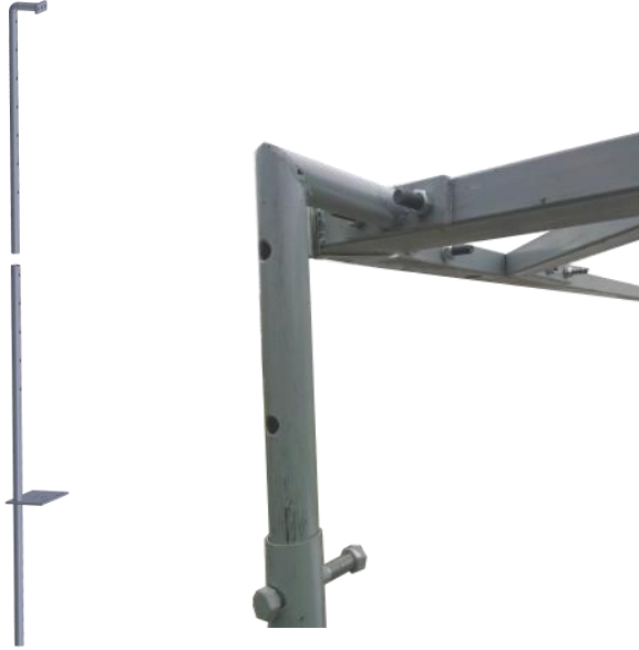
Şekil 3.13. Taşıyıcı ayak model görünümü ve bağlantı şekli
