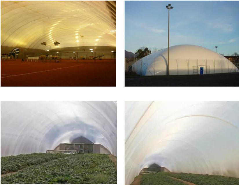
Şekil 1.2. Tümüyle şişirilen sistemlere örnekler
