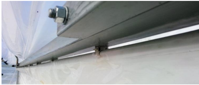
Şekil 3.18. Çatı çerçevesi - yan örtü bağlantısı
