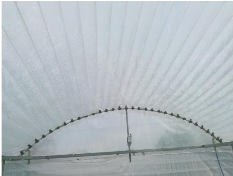
Şekil 3.21. Montajı tamamlanmış çatı örtüsü
