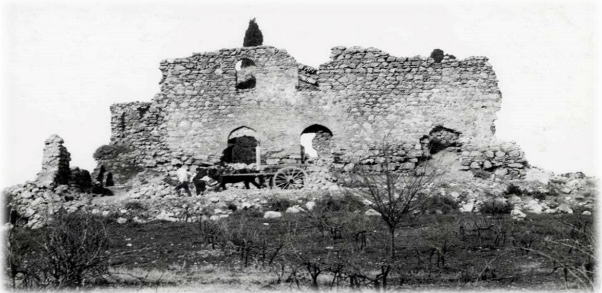
Resim 6: Mevlevîhanenin ön cephesi ait görüntü
