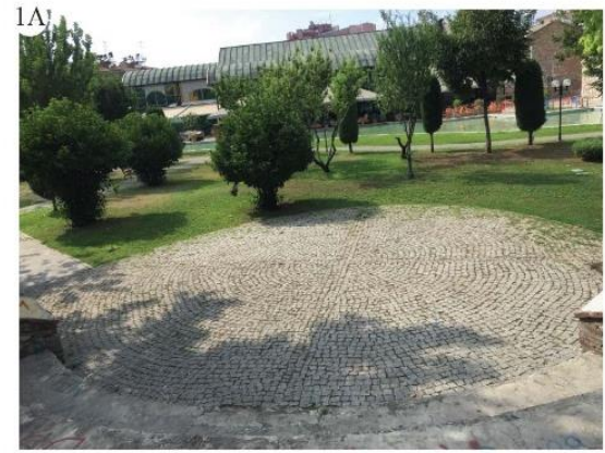
Zemin döşemesi doğal taş döşemeden oluşmaktadır
