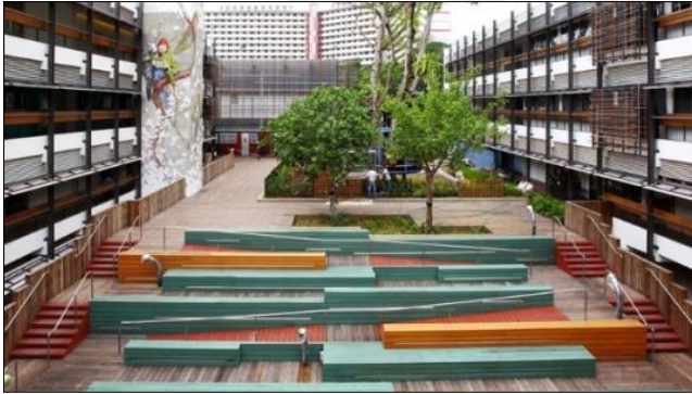
Resim 2.1. Merdiven ve rampalar (Enabling village, 2020)
