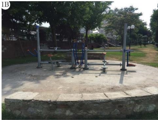
Zemin döşemesi betondan oluşmaktadır
