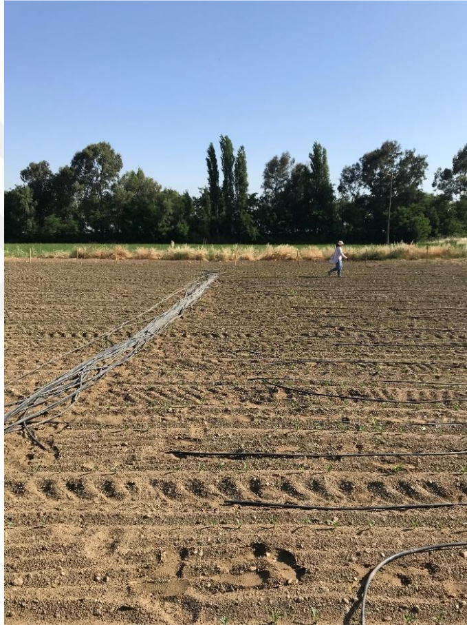
Resim 3.3. Sulama hatlarının ve borularının döşenmesi.
