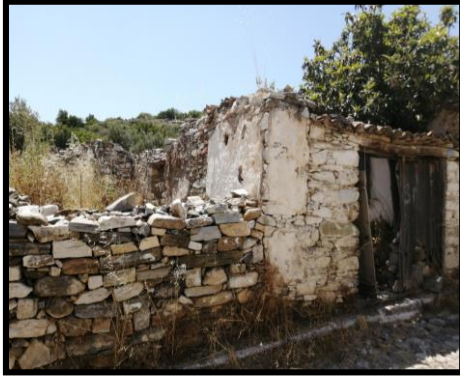
Resim 41. Eski Bina Yapısı (Orijinal)
