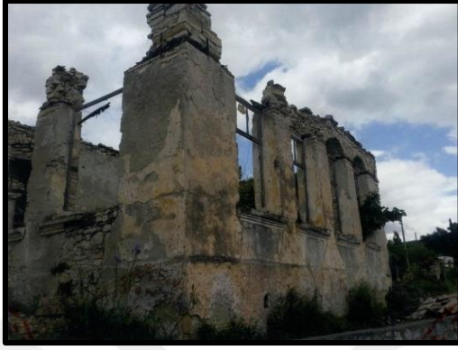
Resim 65. Eski Okul Binası (Orijinal)
