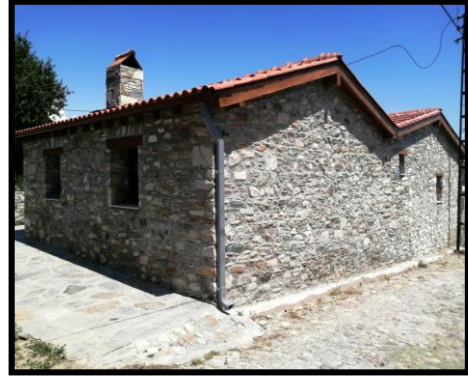
Resim 42. Restore Edilmiş Bina Yapısı (Orijinal)
