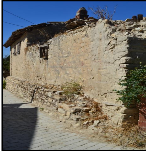
Resim 68. Eski Bina Yapısı (Orijinal)
