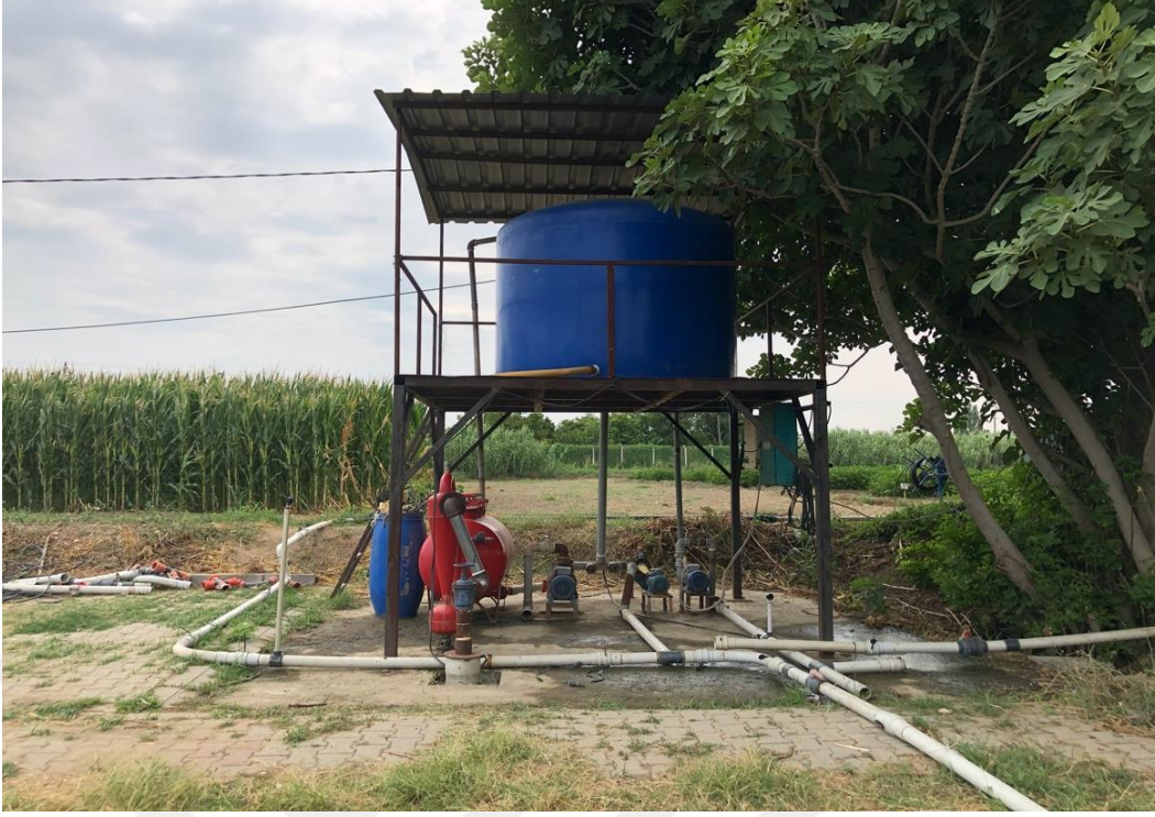
Resim 3.1. Deneme alanındaki sulama sistem unsurları
