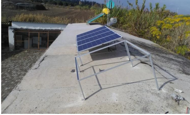
Şekil 3.24. Fotovoltaik Panellerin Montajı İle İlgili Görsel
