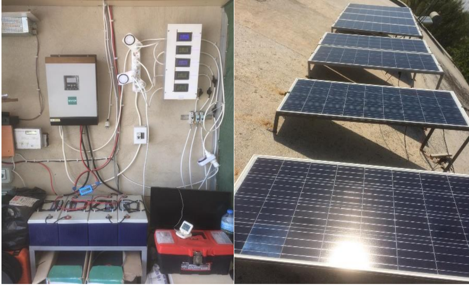
Şekil 3.8 Güneş Enerjisi Sistemi
