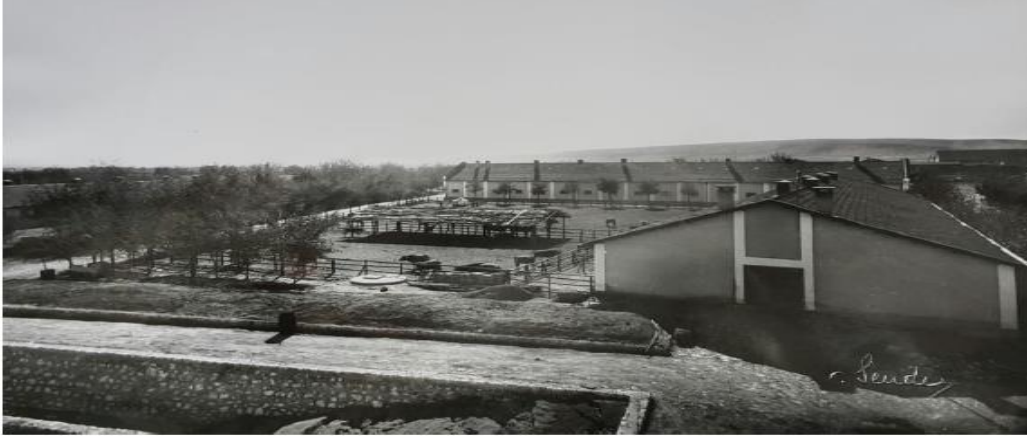
Şekil 5. 15. Eskişehir Şeker Fabrikası çiftlik ahırları
