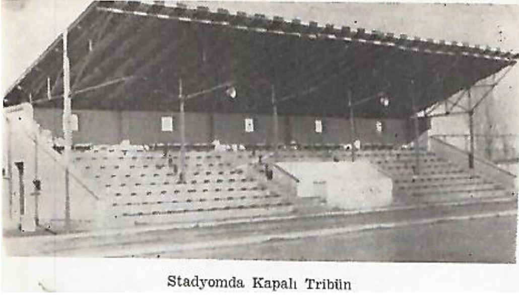
Şekil 5. 1 Uşak Şeker Fabrikası stadyumu.
