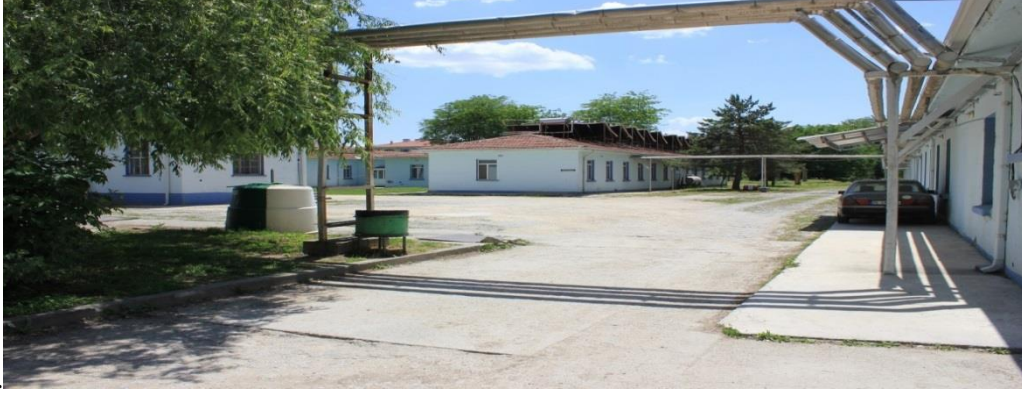
Şekil 5. 61 Eskişehir Şeker Fabrikası işçi pavyonları. Kaynak: Ali Dilek (Haziran, 2018)
