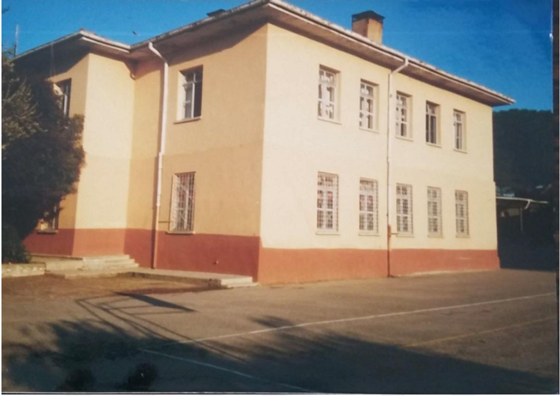
Şekil 3.7. Torbalı Gazi İlkokulu'nun Yıkımdan Önceki Binası
