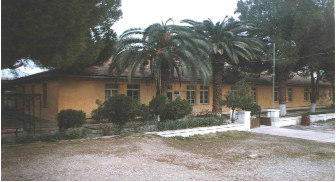
Şekil 3.12. 1954'te Açılan Torbalı Ortaokulu'nun Doğu Cephesinden Görünümü Kaynak: (Kayış, 2012)
