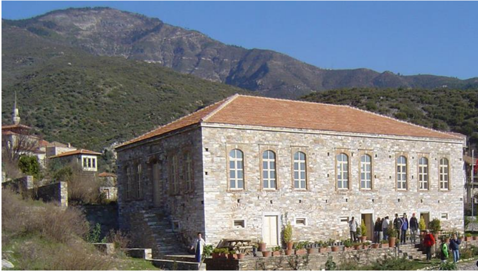
Şekil 4.3. Eski Doğanbey Mahallesi ZTM (DYBM Deltası Milli Park Müdürlüğü Arşivinden)
