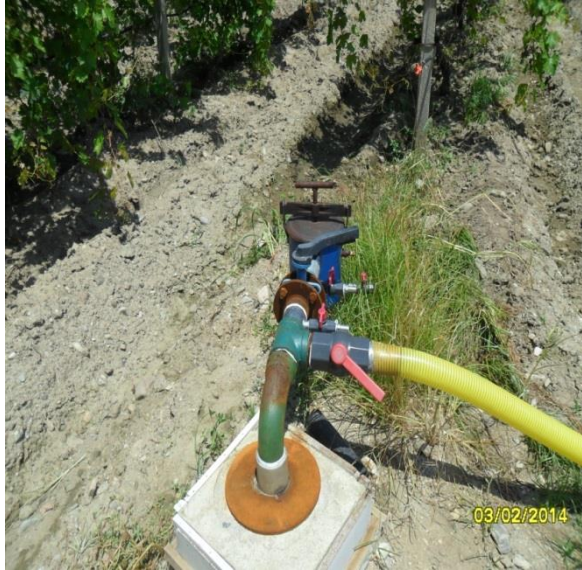
Şekil 3.2. Filtrasyon ünitesinden bir görünüş
