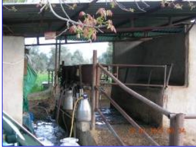
Şekil 3.2 Yarı sabit sağım tesisi
