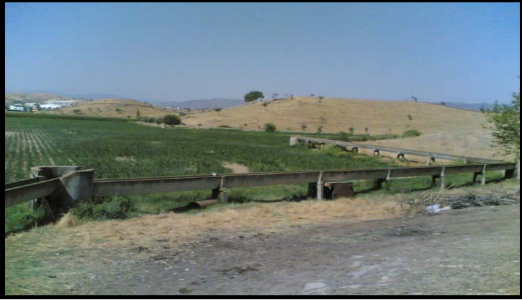
Şekil 3.4. Topçam sulaması yedek kanaletlerinden bir görünüş.
