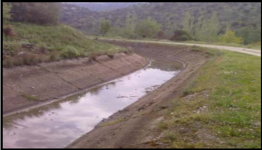
Şekil 3.3.Çine Topçam sulaması ana kanalından bir görünüş.
