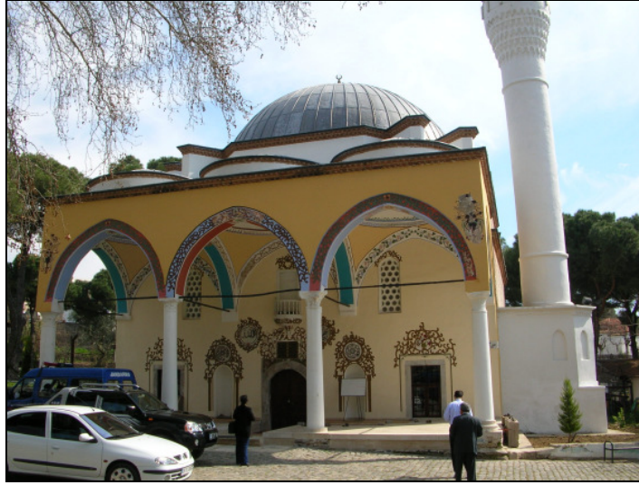
Resim 15: Derviş Ağa Camii, kuzey cephesi
