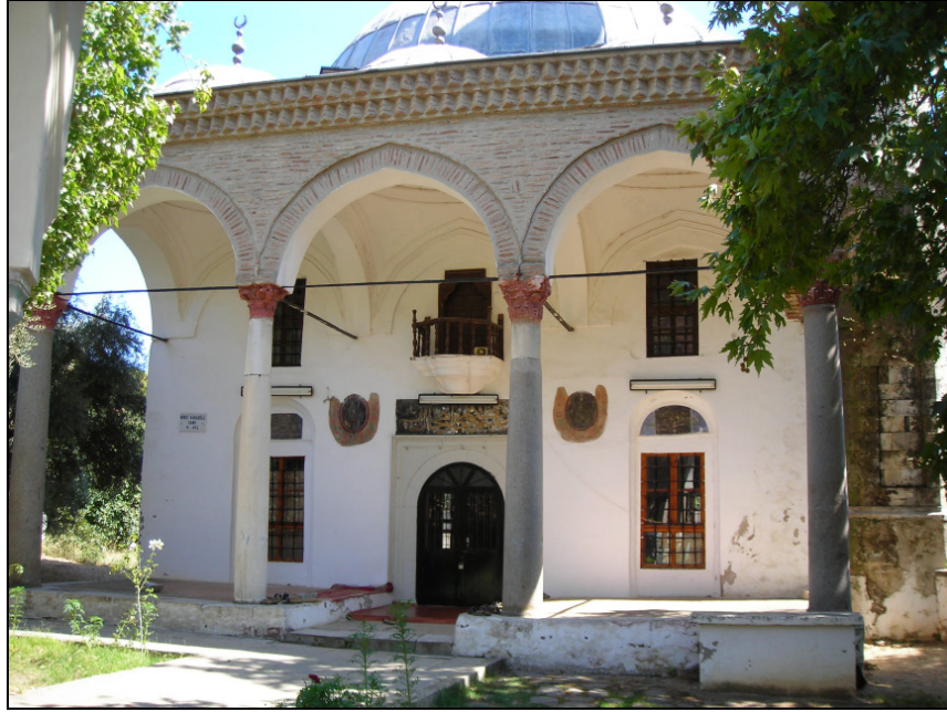
Resim 19: Karaoğlu Camii, kuzey cephesi
