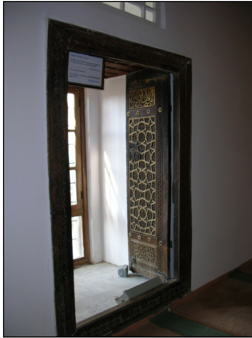
Resim 11: Birgi Ulu Camii, batı duvarındaki pencere kanatlarından birisinin görünümü
