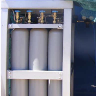
Şekil 3.2. Karbondioksit tüpleri ve karbondioksitin sera içerisine dağıtılmasını sağlayan boru hattı
