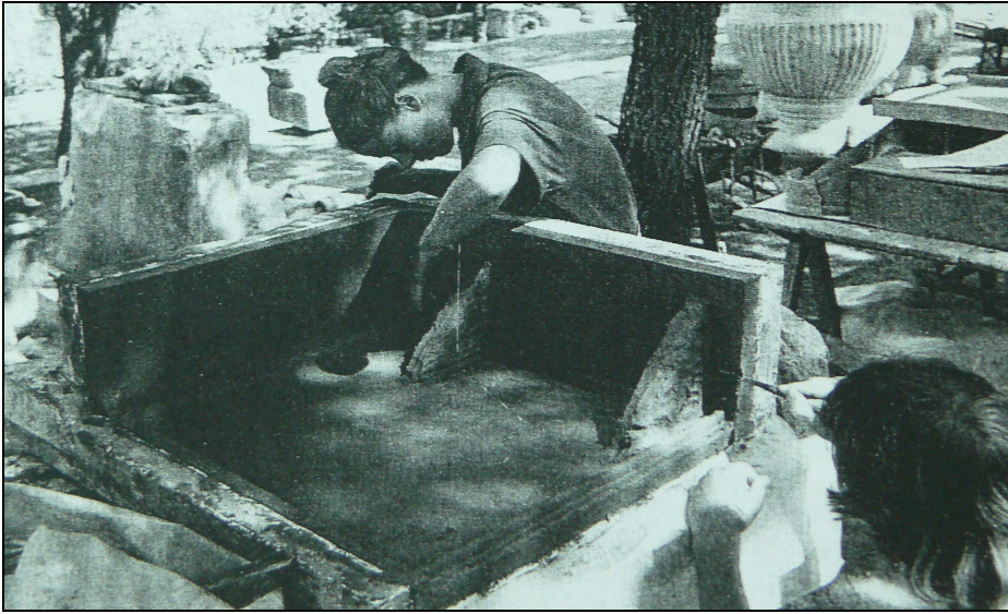
Figür 5. "Lydia Evi" köşe siması kalıplanması
