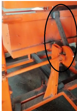
Resim 3.21. Eksantrik mekanizması revizyonu
