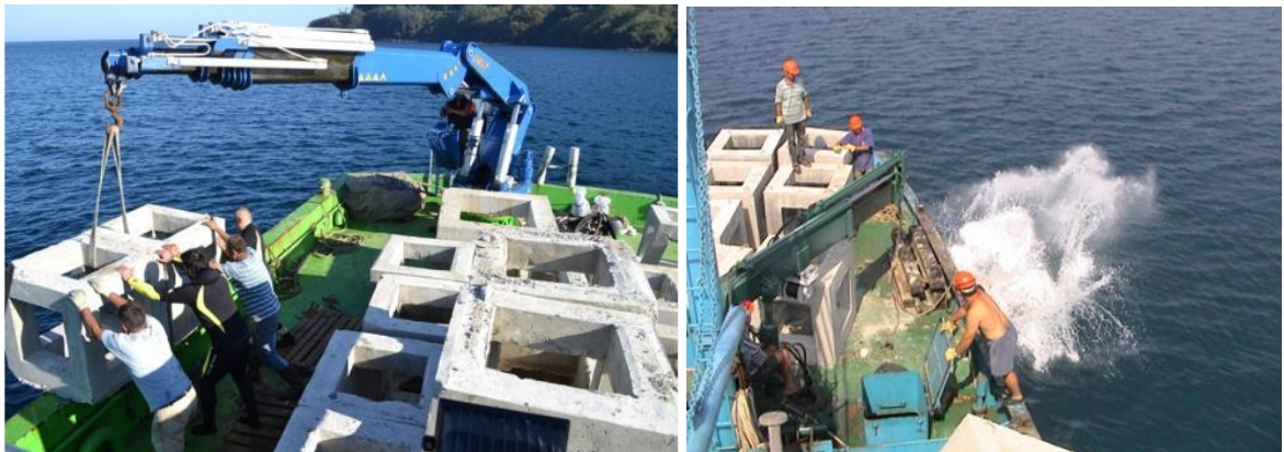
Şekil 3.3. Yapay resif bloklarının taşınması ve suya bırakılması (Aydın ve Altaş, 2015)
