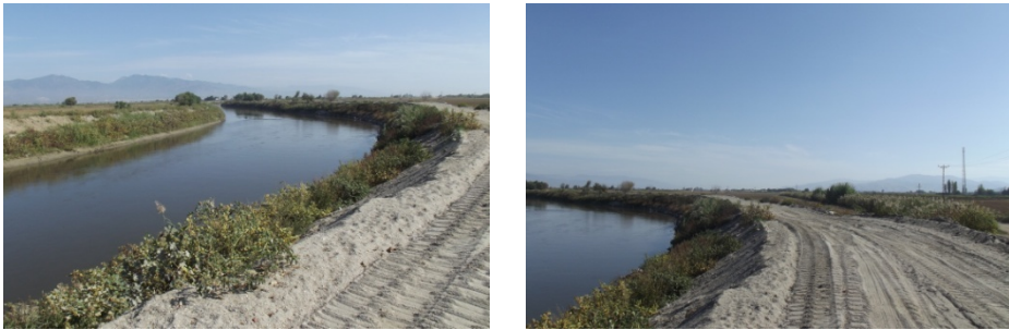
Şekil 4.19. DSİ tarafından yapılan ıslah çalışmaları sonrası görüntüsü
