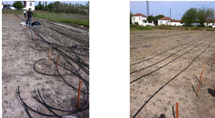
Şekil 3.11. Damlama sulama sisteminin kurulması
