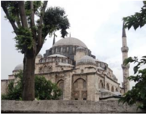
Şekil 4.13 Mimar Sinan tarafından yapılan Şehzade Mehmed Camii
