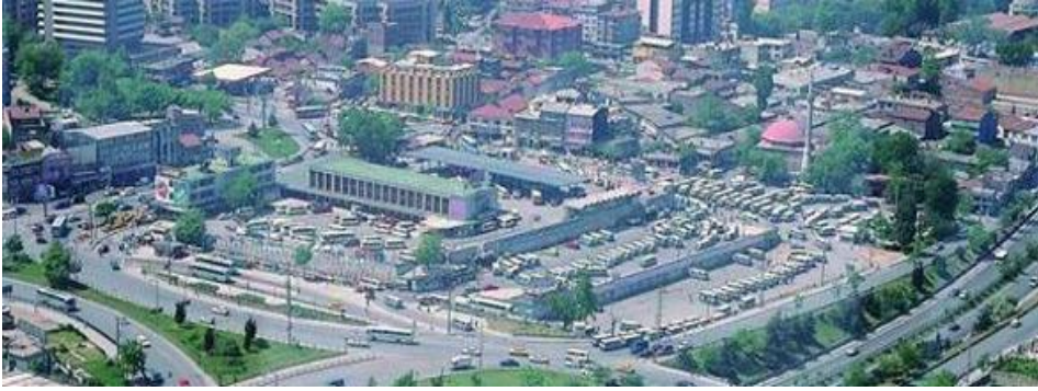
Şekil 4.5. Santral Garaj Bölgesi
