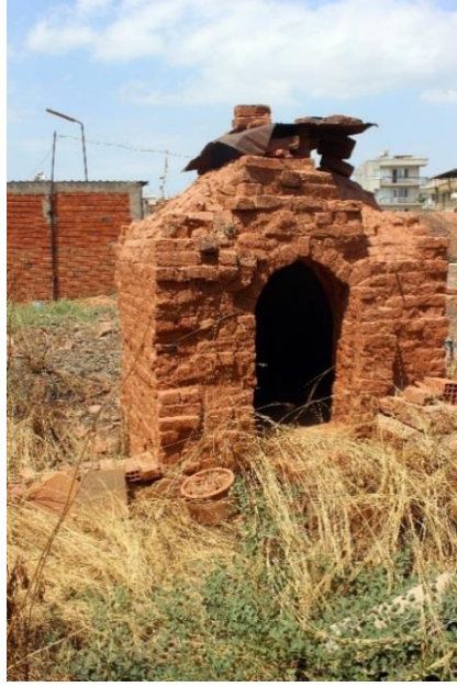
Resim 2.42. Menemen’deki bir çömlekçi atölyesinin bahçesindeki minyatür fırının ön kısmı (Esin Biberoglu arşivi)
