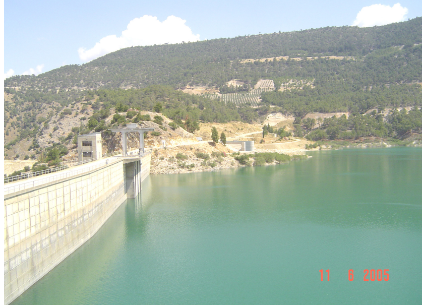
Şekil 8. Kemer Barajı'ndan Bir Görünüm
