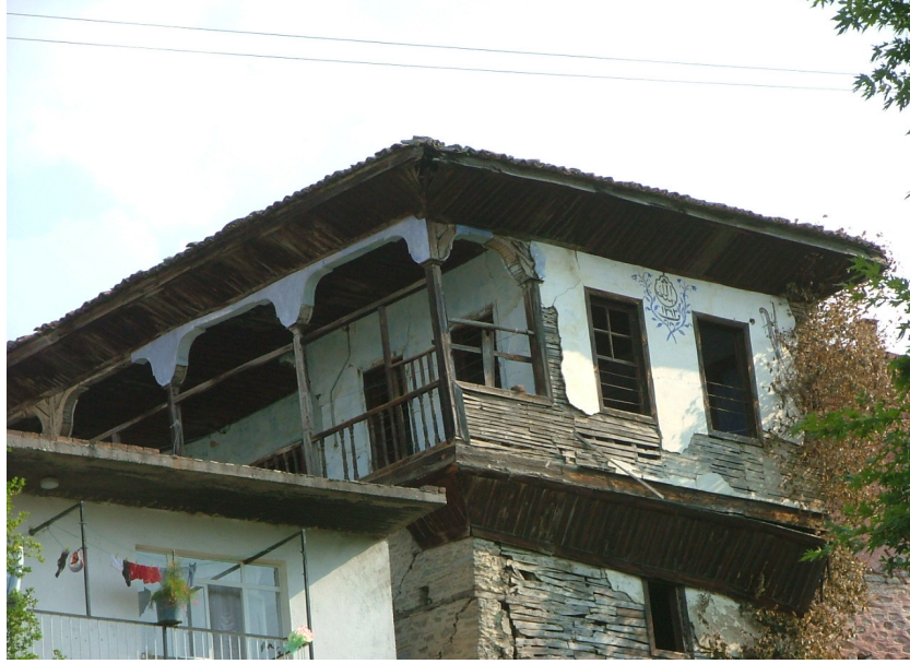
Şekil 80. Kallemler Konağı Yan Cephe
