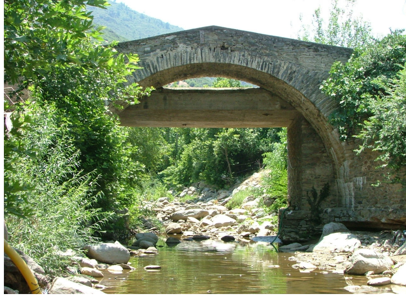
Şekil 56. Kazandere Köyü'ndeki Köprü
