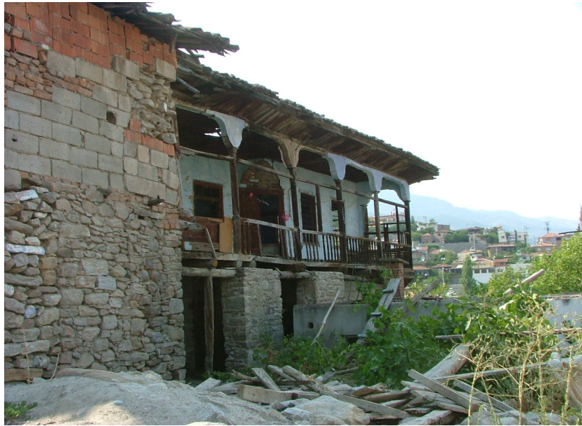
Şekil 79. Kallemler Konağı Ön Cephe
