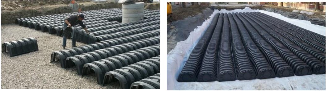
Şekil 4.18. Yağmur suyu depolama sistemleri boru döşemesi (Anonim, 2013a).
