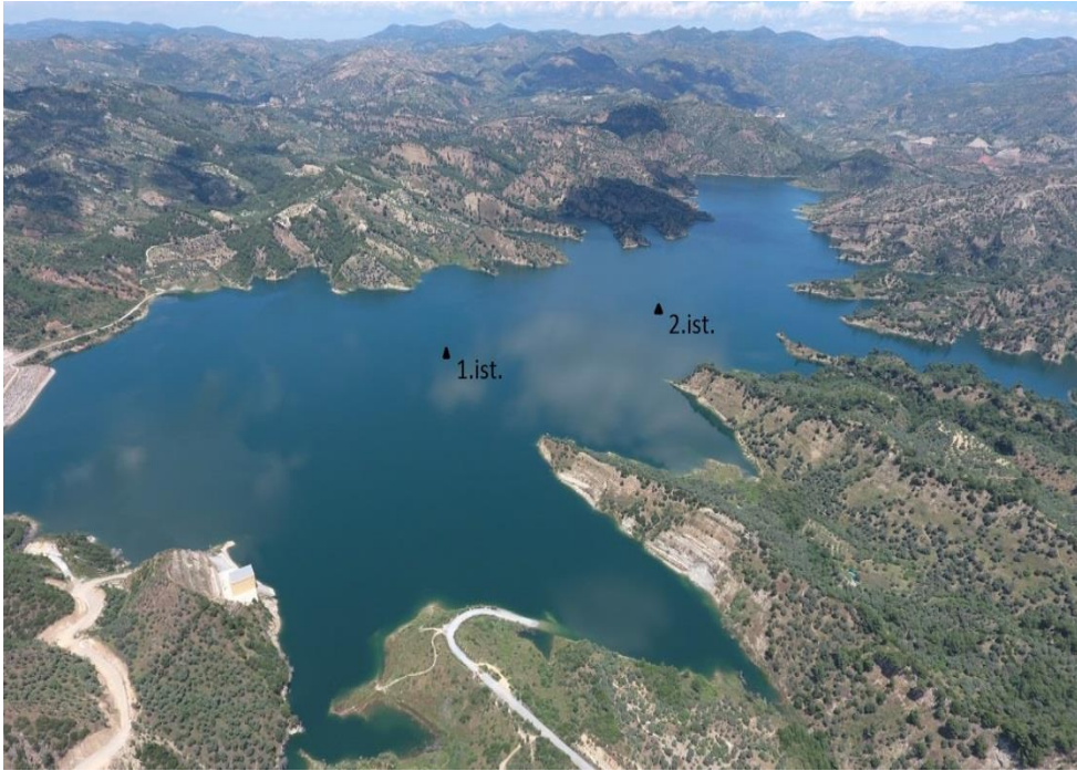
Şekil 3.2. İkizdere Barajı 1. ve 2..istasyon
