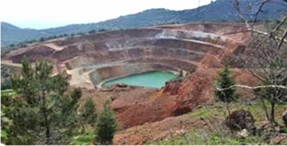
Resim 6.1. Siyanürlü Altın Madeni İşletmesinin Atık Depolama Tesisi.
