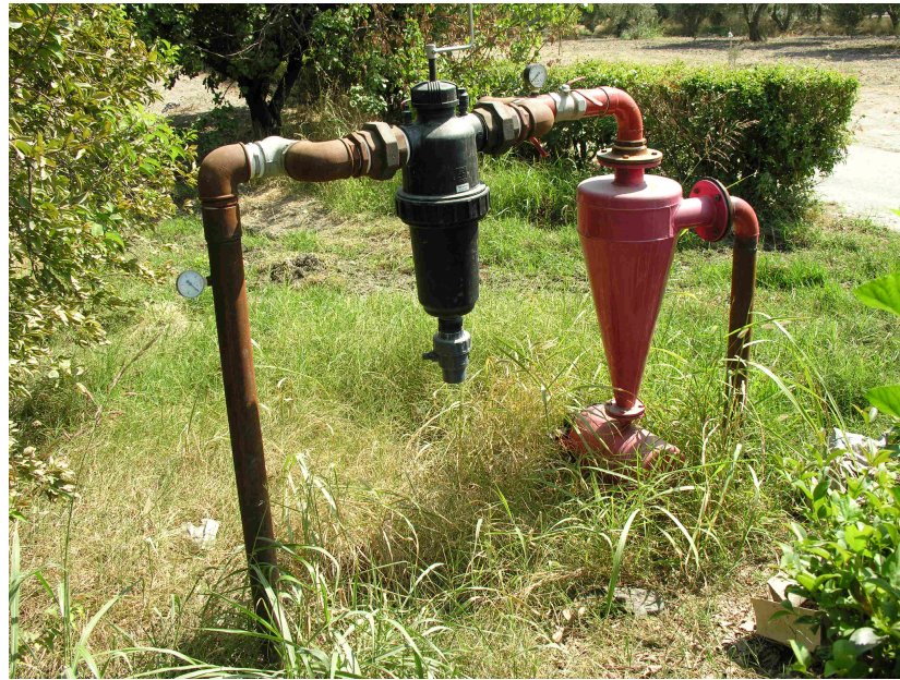
Şekil 3.3. Filtrasyon ünitesinden bir görüntü
