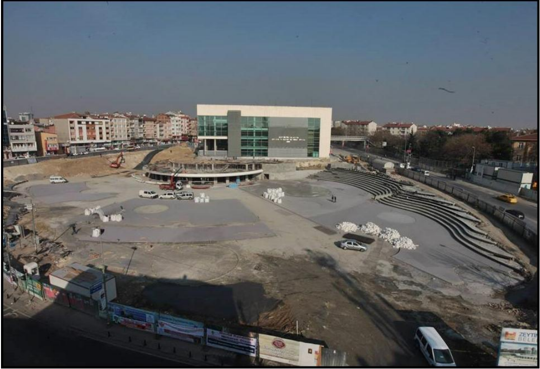
Fotoğraf 23: Yenileme çalışmaları çerçevesinde Zeytinburnu Kültür Merkezi yapım çalışmalarından görüntü ( www.facebook.com/zeytinburnu10 )
