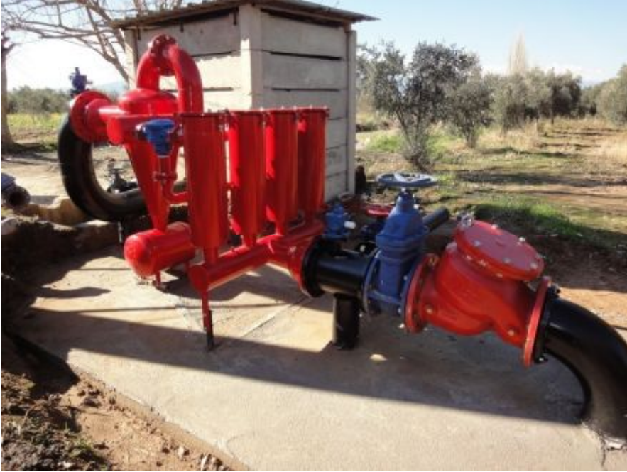
Şekil 4.1 Kuyu başlarında bulunan merkezi kontrol ve filtreleme ünitesi.
