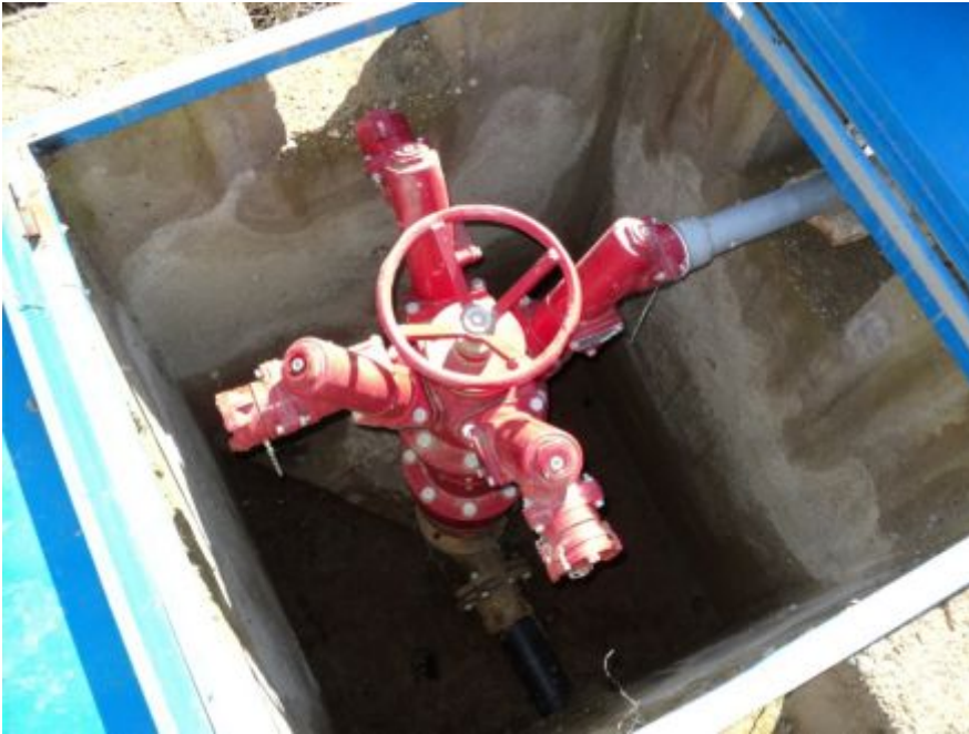
Şekil 4.17 Dört çıkışlı, üstten vanalı mekanik hidrant.
