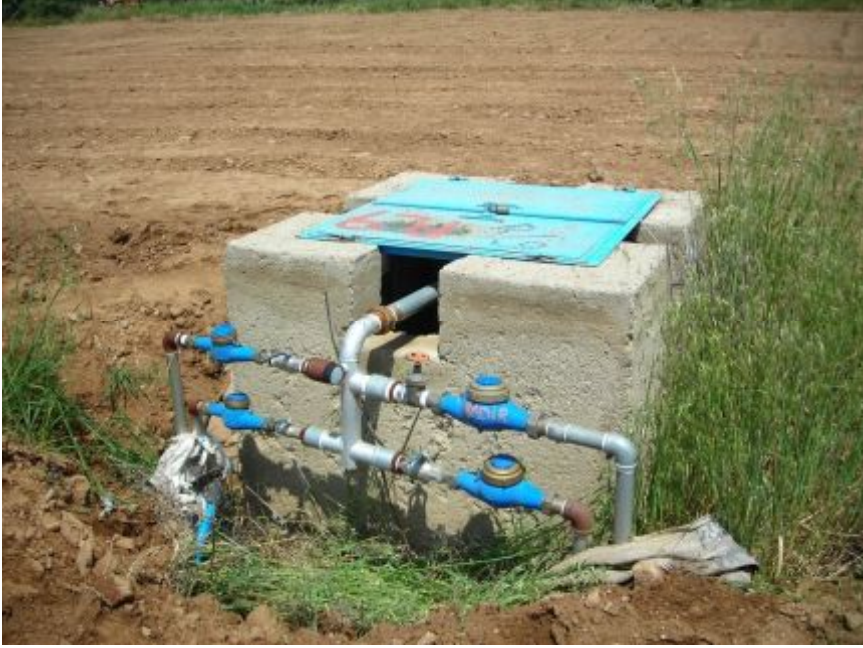
Şekil 4.13 Hidrant rögarı ve parsellerin su sayaçları.
