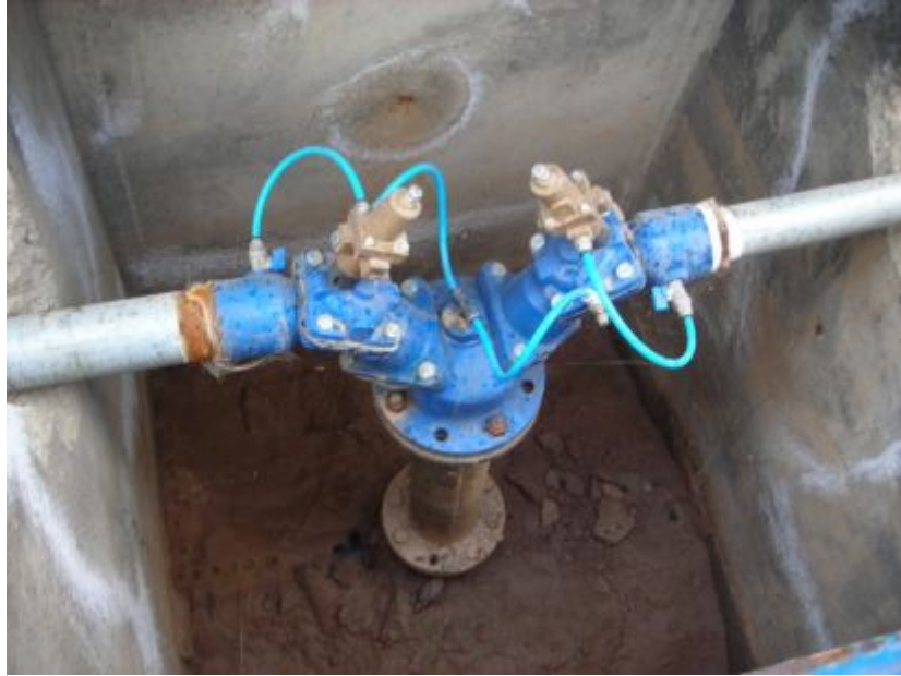
Şekil 4.18 İki çıkışlı, basınç pilot üniteli (basınç ayarlamalı) hidrant.
