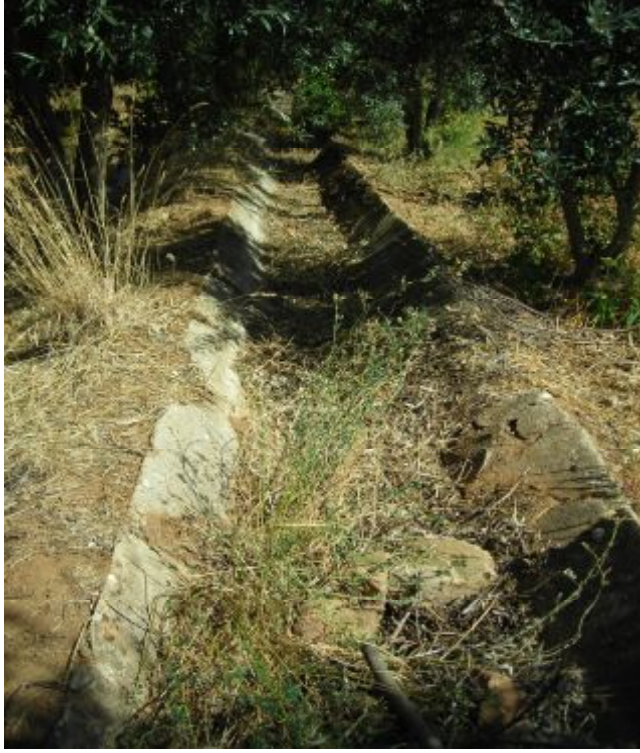
Şekil 3.5 Kullanım ömrünü doldurmuş ve yıpranmış yüzey sulama kanalı.
