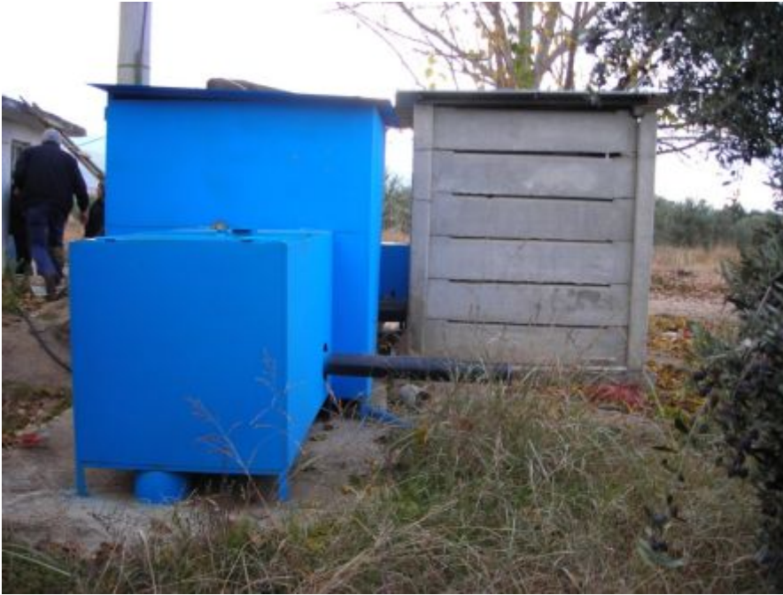
Şekil 4.2 Kuyu başlarında bulunan merkezi kontrol ve filtreleme ünitesinin muhafaza içine alınmış hali.
