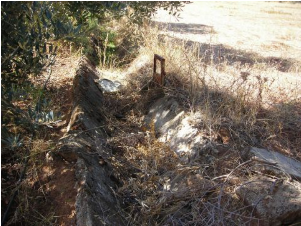
Şekil 3.4 Kırılmış ve bakımı yapılmamış yüzey sulama kanalı.
