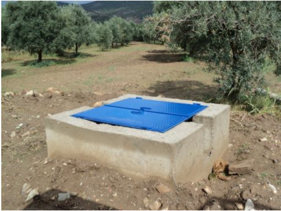
Şekil 4.16 Müteahhit firmanın yaptığı hidrant muhafaza rögarı ve kapağı.
