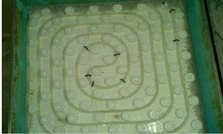
Şekil 3.12. Alttan ısıtma borusunun yerleştirilmesi
