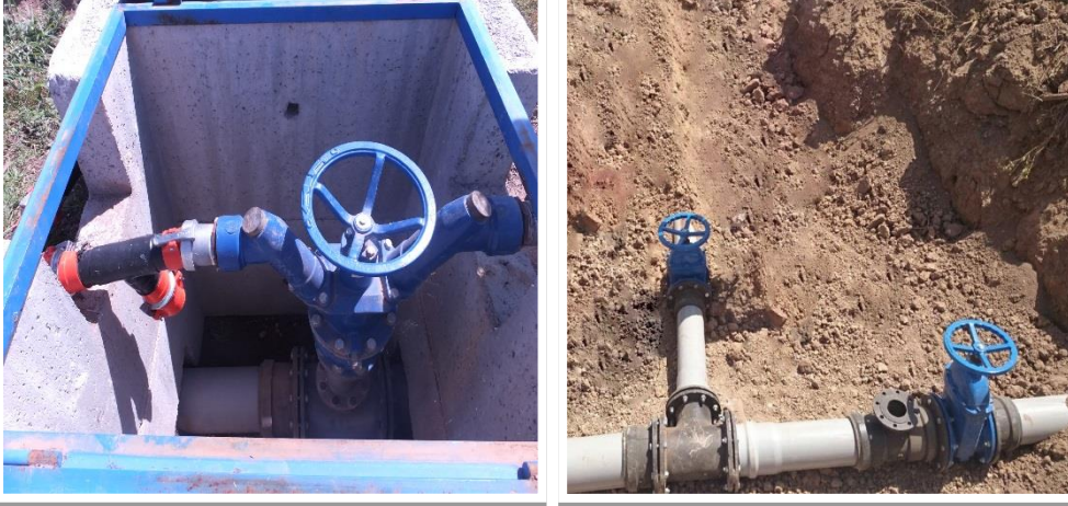
Şekil 4.1. Yağmurlama sulama sistemindeki hidrant ve ayırım noktası
