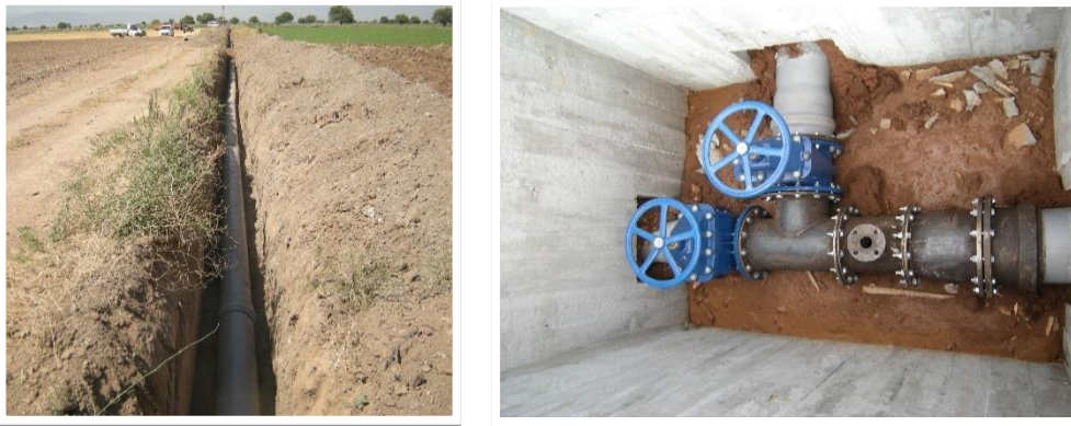
Şekil 4.2. Yağmurlama sulama sistemi boru hattı ve ayırım rögari
