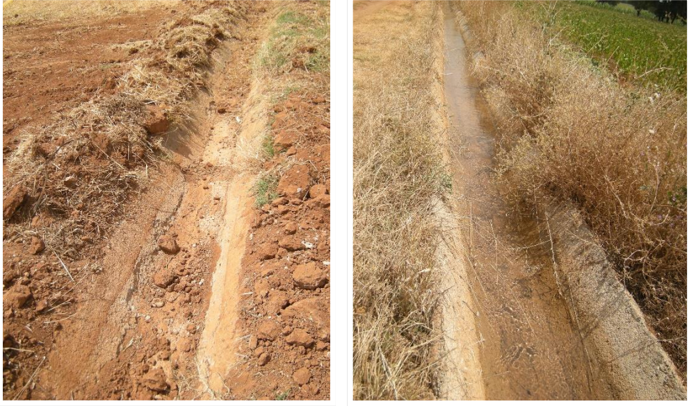
Şekil 3.2. Açık kanal sulama sistemi kanalları
