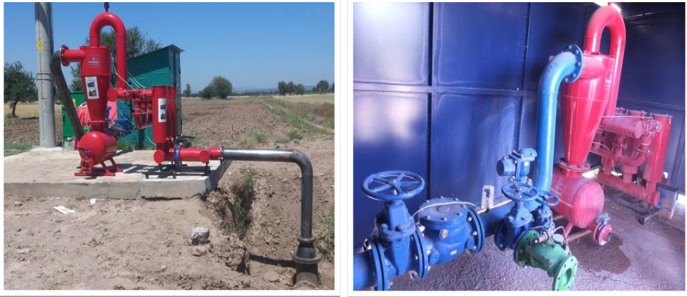
Şekil 3.3. Pompa evi-kontrol ünitesi
