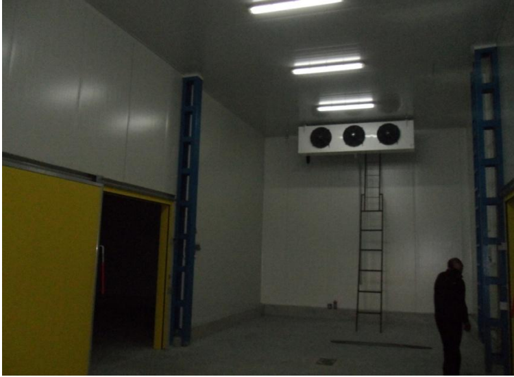
Şekil 4.12 Duvar ve tavan yalıtım malzemesi olarak PU panel kullanılan bir işletme (Sultanhisar)
