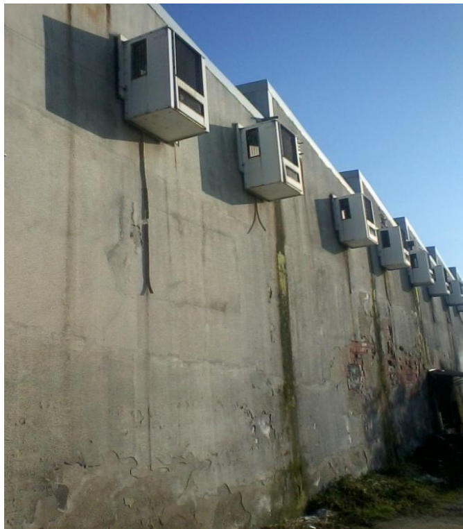
Şekil 4.24 Su yalıtımı iyi yapılmamış bir işletme (İncirliova).
