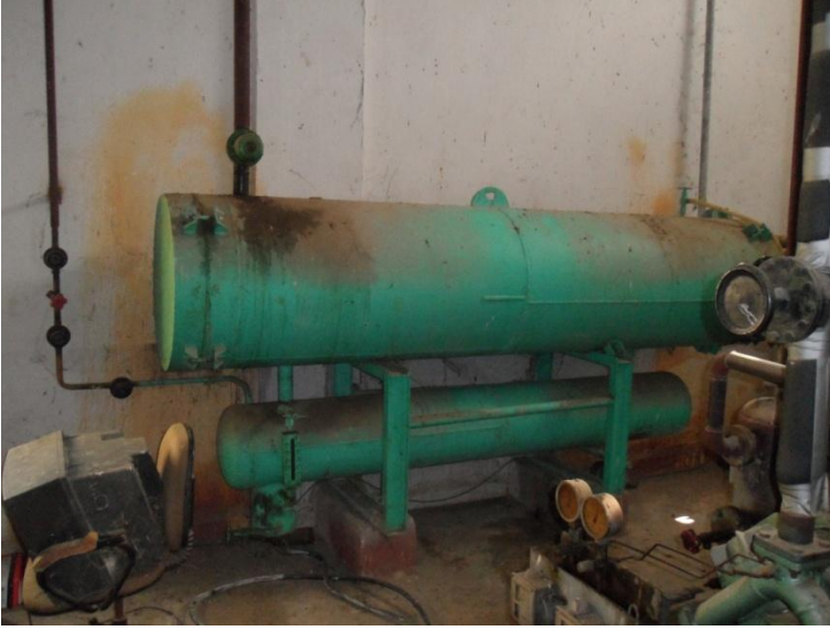
Şekil 4.25 Gereklı bakım işlemleri zamanında yapılmamış bir soğutma sistemi (Nazilli)
