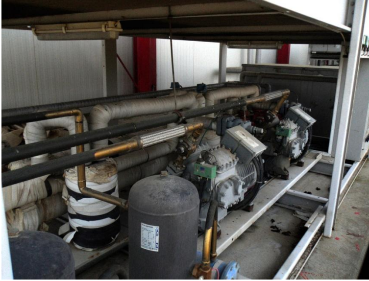
Şekil 4.18 Kontrollü atmosferli (freon gazlı) soğutma sistemi kullanılan bir işletme (Nazilli).
