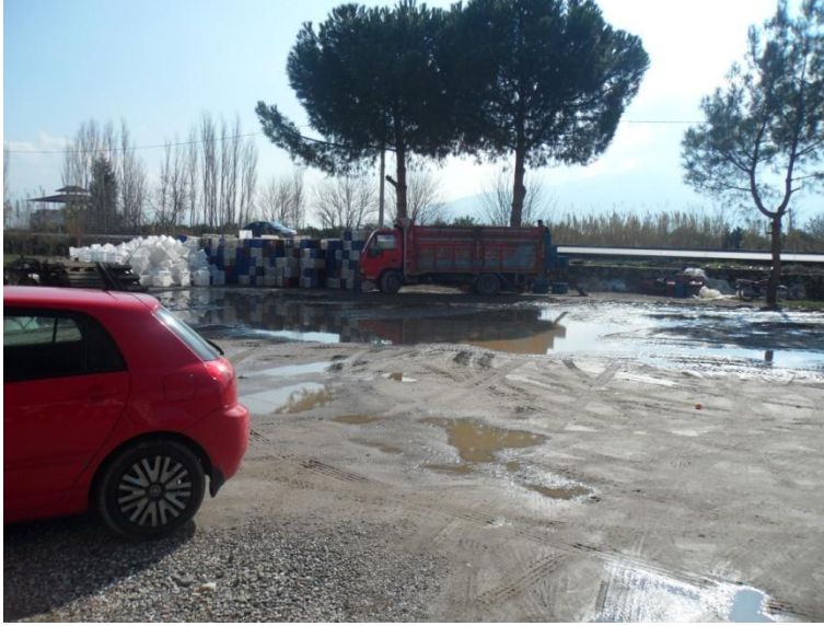
Şekil 4.23 İşletme avlusunda drenaj problemi olan bir işletme (Nazilli).
