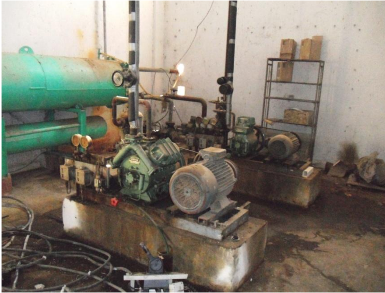
Şekil 4.19 Soğutkan olarak amonyak gazı kullanan bir soğuk hava deposu (Nazilli).
