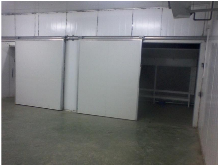
Şekil 4.6 Soğutkan olarak freon gazı kullanan bir soğuk hava deposunun ön soğutma odası (Sultanhisar).
