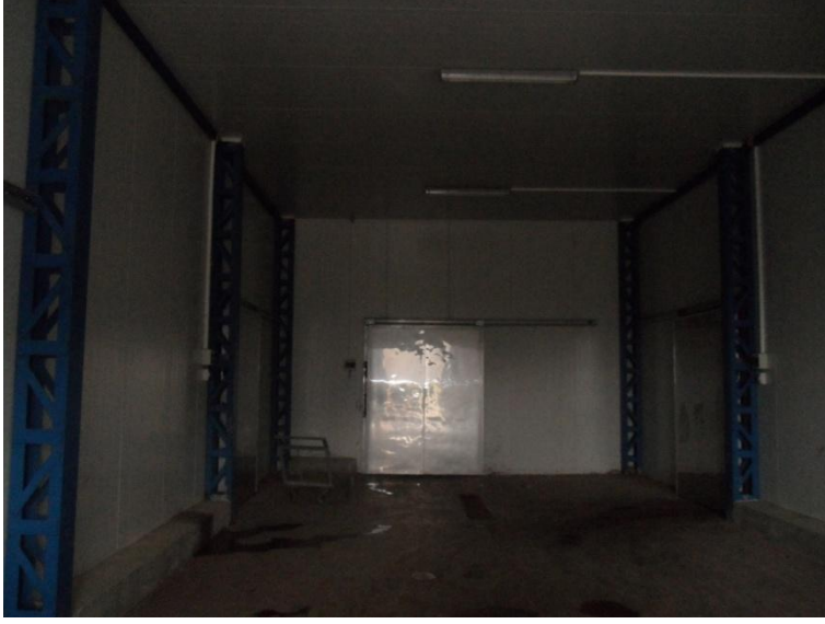
Şekil 4.10 Deposunda taşıyıcı sistem olarak çelik konstrüksiyonu kullanan bir işletme (Kuyucak)
