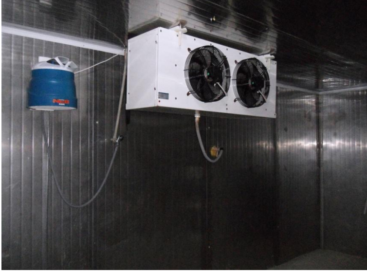
Şekil 4.15 Duvar ve tavan yalıtım malzemesi olarak alüminyum panel kullanılan bir işletme (Kuyucak).
