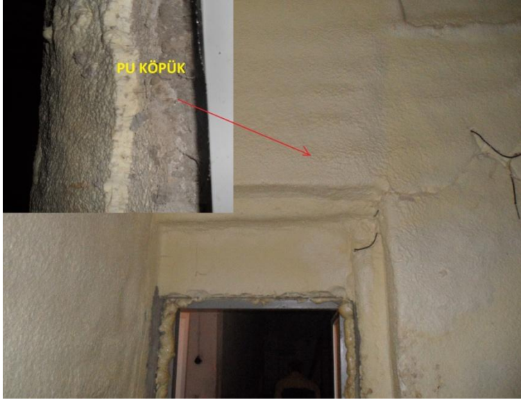
Şekil 4.14 Duvar ve tavan yalıtım malzemesi olarak PU köpük kullanılan bir işletme (Kuyucak).
