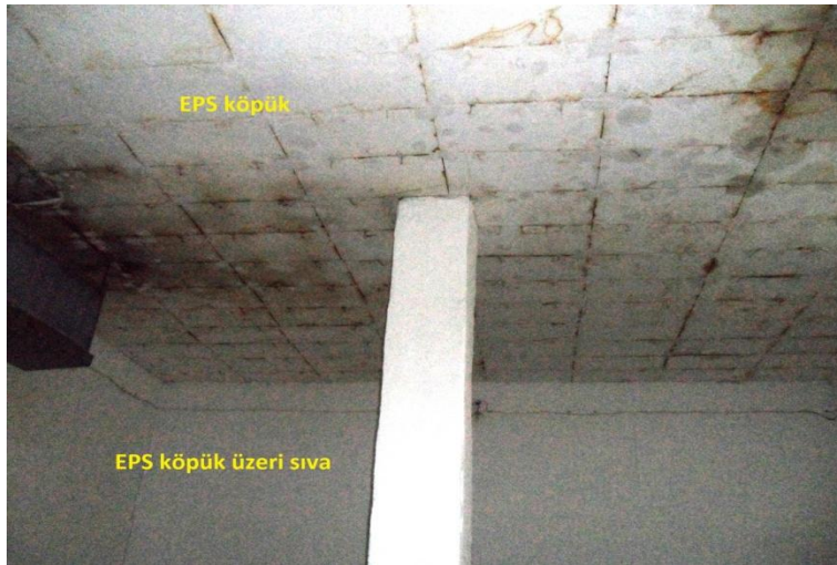
Şekil 4.13 Duvar ve tavan yalıtım malzemesi olarak EPS köpük kullanılan bir işletme (Nazilli).
