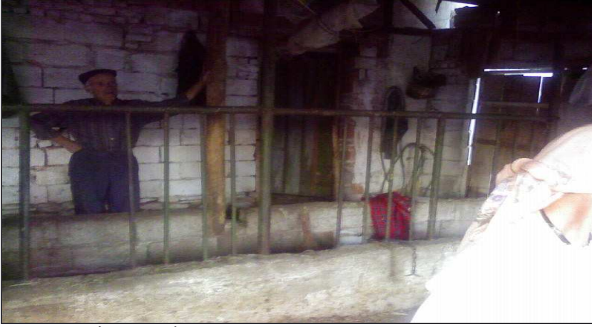
Şekil 4.11. İki Nolu İşletmeye Ait Ahırdan Bir Görüntü
