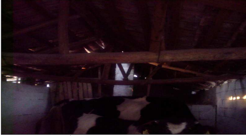
Şekil 4.5. Bir Nolu İşletmeye Ait Ahırdaki Çatı Altından Bir Görüntü
