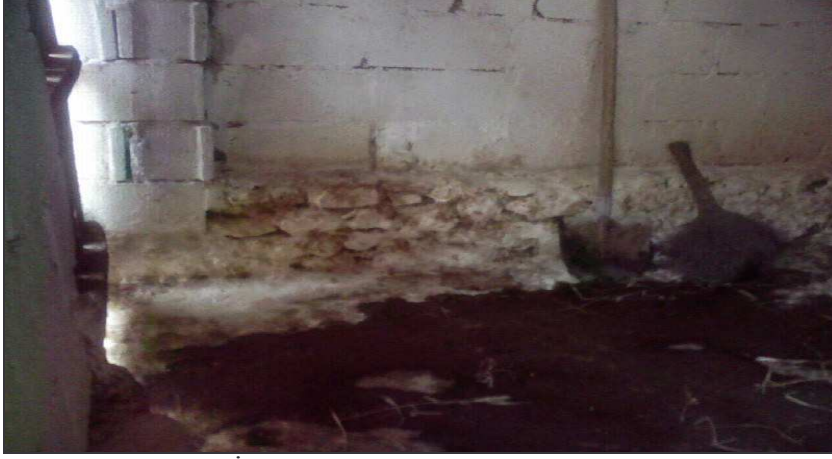
Şekil 4.4. Bir Nolu İşletmeye Ait Ahır Duvarından Bir Görüntü
